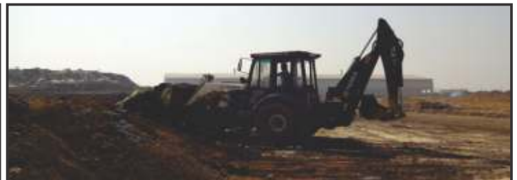
SOLID WASTE LANDFILL SITE
